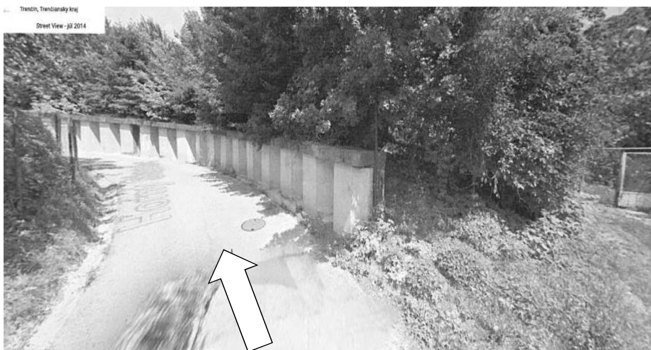
OPORNÝ MÚR NA UL. HORNÝ ŠIANEC
