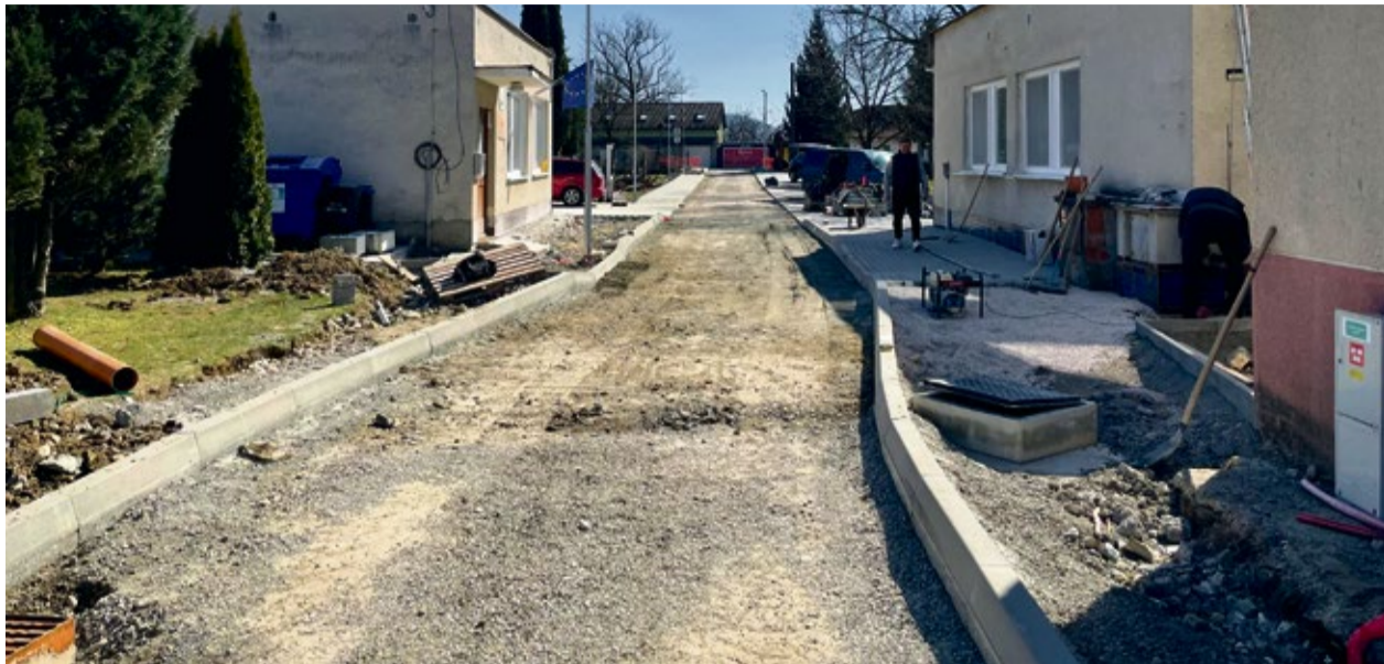
Priebeh stavebných prác na ulici Ľuborčianska
