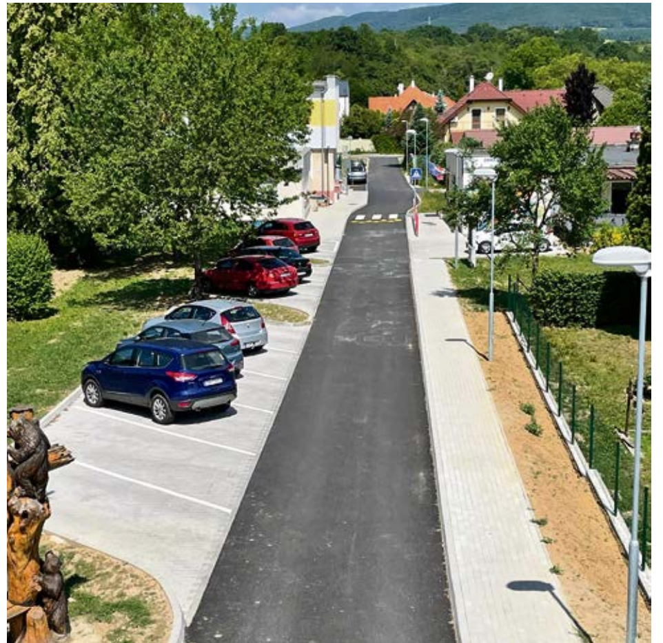
Rekonštrukčné práce na Ľuborčianskej ulici ukončené
