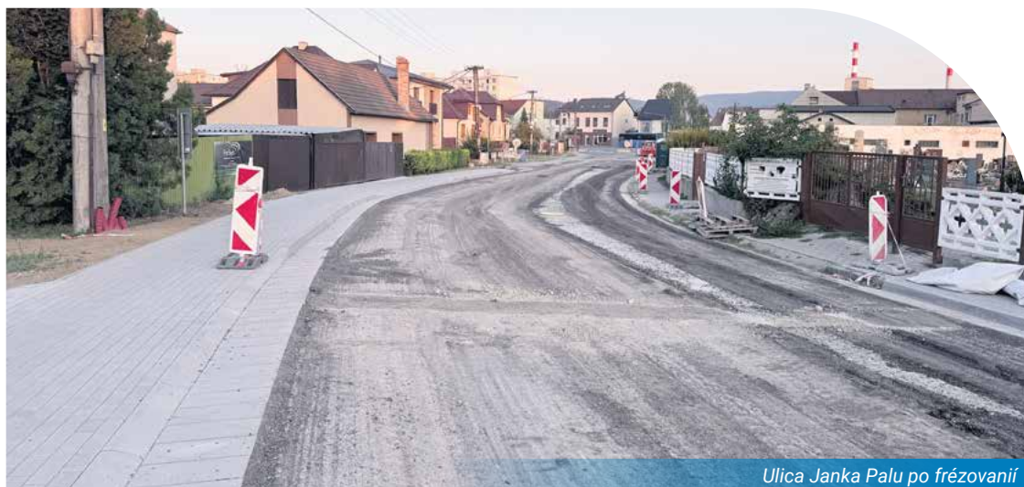
Uloženie nového potrubia
