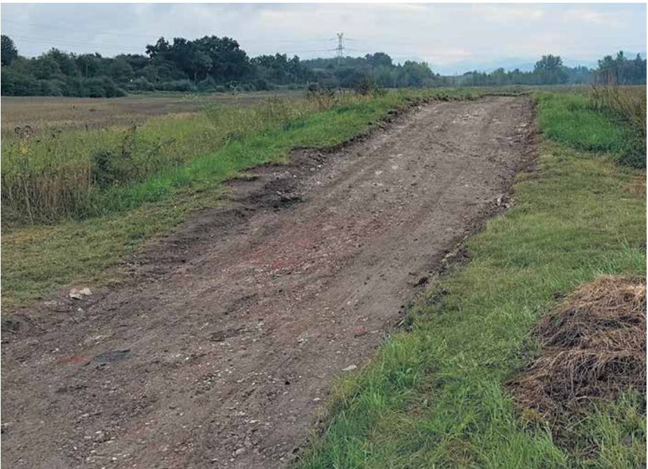
Cyklotrasa od lávky smer Nemšová počas rekonštrukcie
