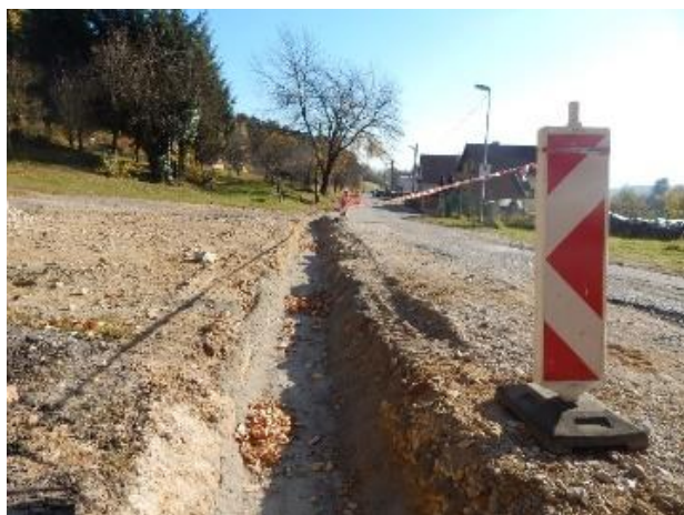
24 Prebiehajúce práce na odtokovom žľabe v Závade, zdroj: Archív kronikárky
