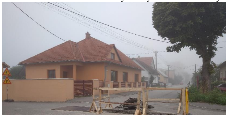
18 Rozkopávka plynu na Vážskej ulici, zdroj: Archív kronikárky
