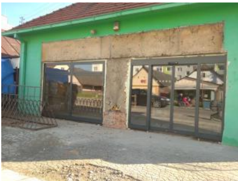
50 Potraviny 365 počas rekonštrukcie, zdroj: archív kronikárky
