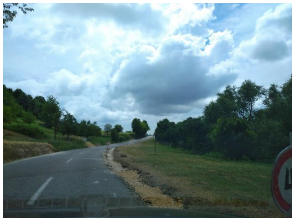
26 Prebiehajúce práce na rekonštrukcii cesty z Tr. Závade, zdroj:archív kronikarky
