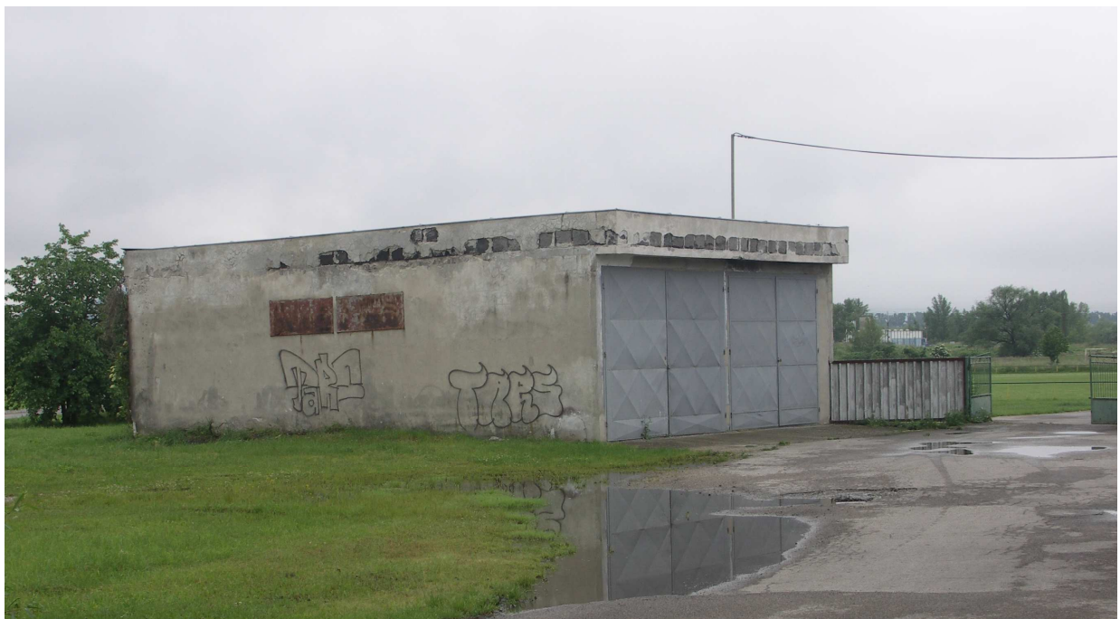
Garáže po rekonštrukcii
