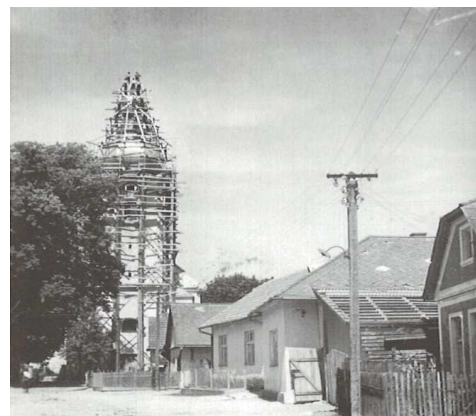
Historická fotografia z opravy kostolnej veže
