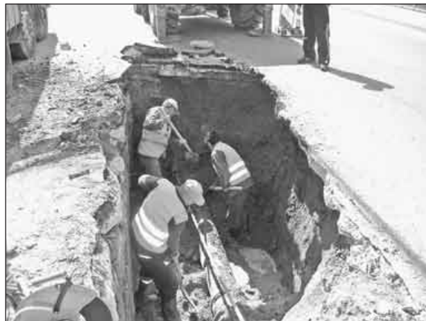
Práca na opravu poruchy UI. SNP Nemšová
