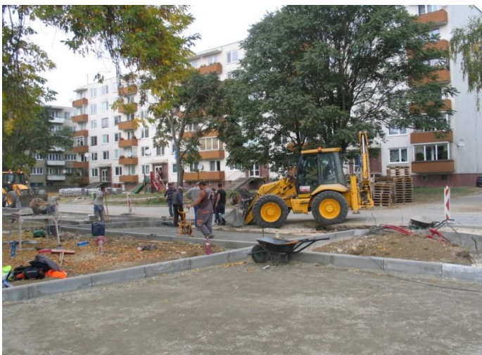
Vytvorenie nového parkoviska na Sklárskej ulici
