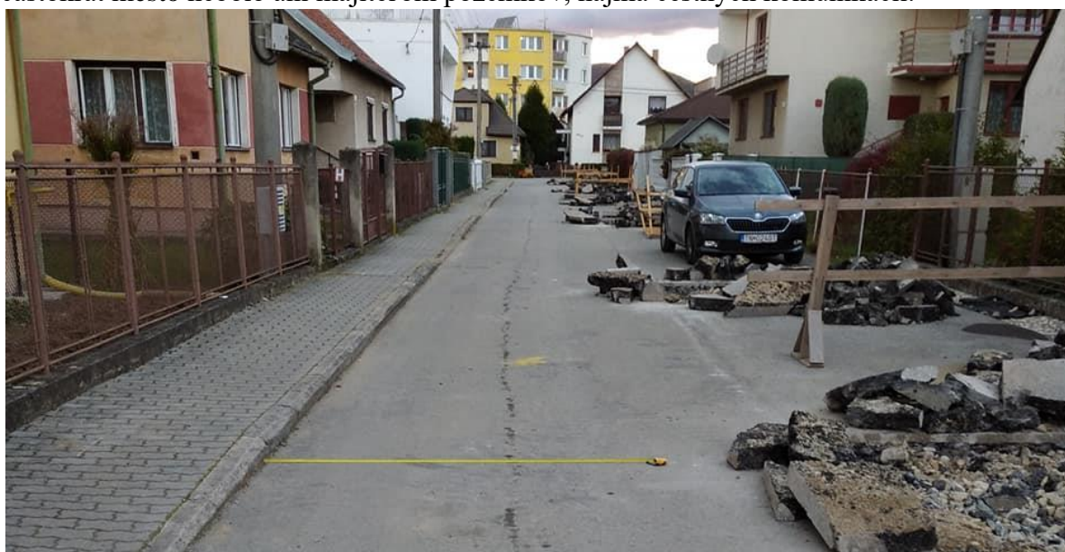
17 Rozkopávka ulice na Ulici 9. mája, zdroj: Archív kronikárky
