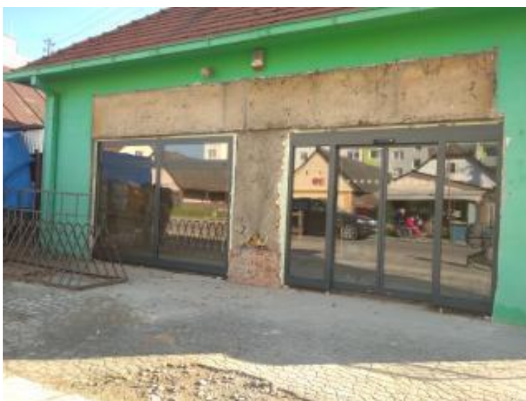
50 Potraviny 365 počas rekonštrukcie, zdroj: archív kronikárky
