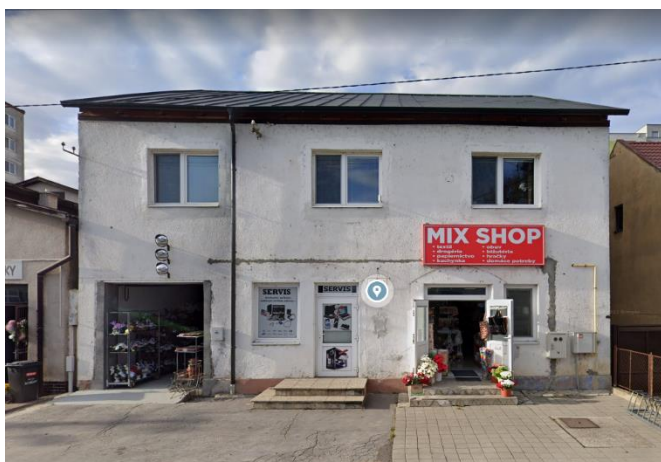
51 Budova s novo otvorenou predajňou rozličného tovaru, zdroj: Archív kronikárky
