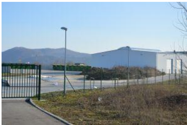
Vybudované Regionálne centrum biologicky rozložiteľných odpadov v Luborčiči
