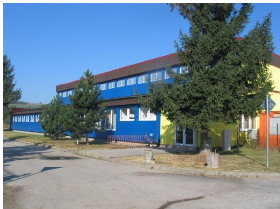
Celkový pohľad na zateplenú budovu športovej haly
