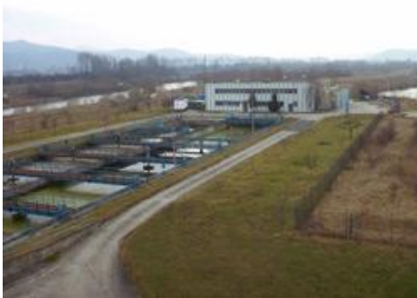
Čistička odpadových vôd v Nemšovej
