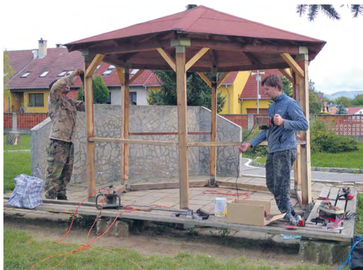
Rodičia pri rekonštrukcii altánku v MŠ Kropáčoho (Foto: Archív MsÚ)
