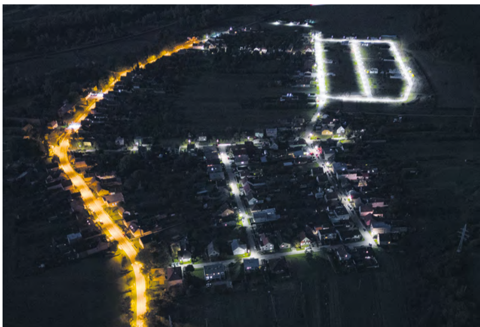
Verejné osvetlenie v Klúčovom pred výmenou
