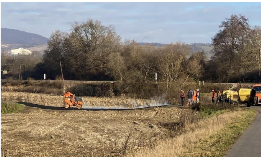
Oprava cyklotrasy Nemšová - Horné Srnie
