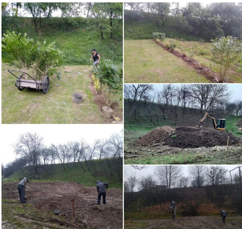
Úprava terénu na ihrisku Nad Cigánom
