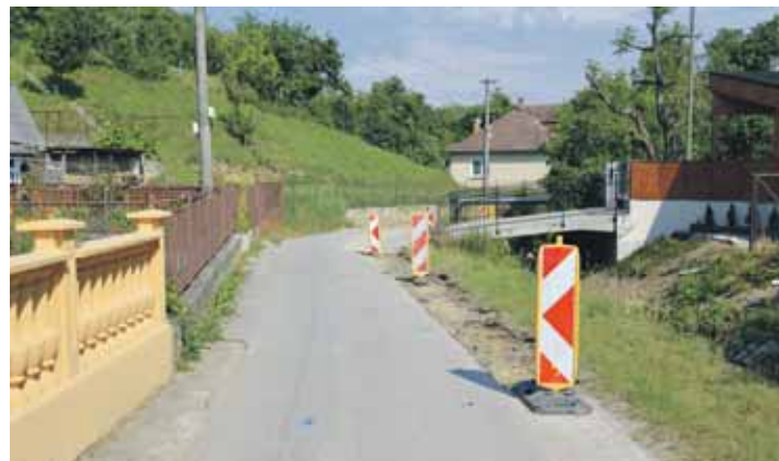
Ľuborča, Kukučínova ul. - práce na kanalizácii
