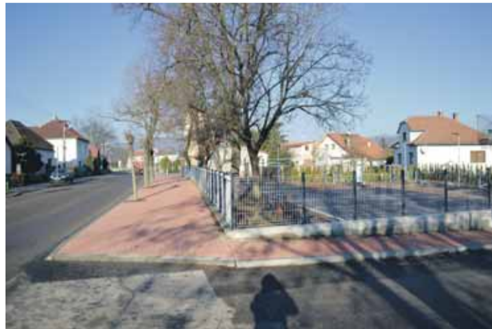
Rekonštrukcia chodníka na Ulici SNP
