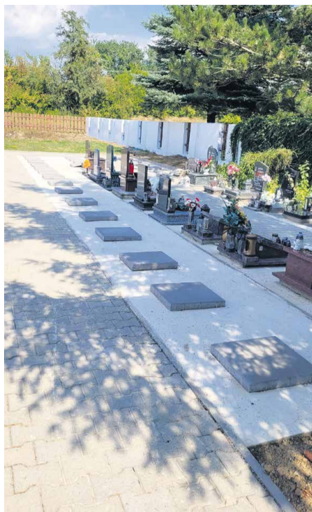
Rekonštrukcia urnového hája
